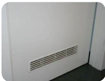
L'ouverture basse pour l'arrivée d'air doit être installée le plus près possible du sol et doit disposer d'une ouverture non-obturable de minimum 150cm<sup>2</sup>.
