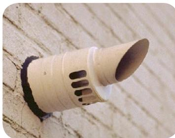
Un appareil étanche fonctionne indépendamment de l'air de la pièce. Par conséquent, le risque d'intoxication au CO est inexistant.
